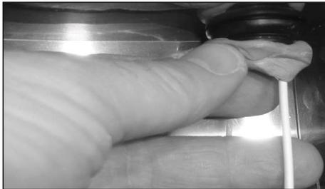
10. Die Bohrung innen mit Spachtelmasse verschließen.
