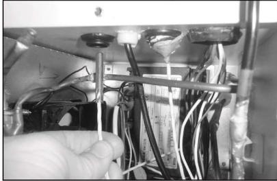
8. Den Sensor einführen und vollständig durch das Rohr schieben.
