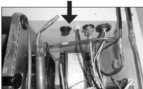
4. Im Inneren befindet sich die Anschlussbohrung oben rechts und ist mit einem Gummistopfen verschlossen.
